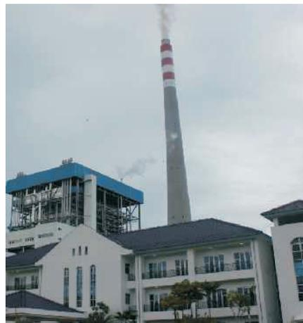
Gambar 3.1 Cerobong masih keluar fly ash
